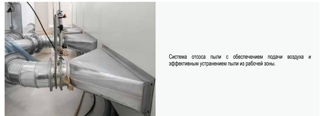
Система отсоса пыли с обеспечением подачи воздуха и эффективным устранением пыли из рабочей зоны.
