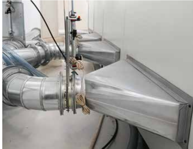
Sistema di aspirazione polveri per un efficace ricambio aria ed abbattimento polveri all'interno dell'area di lavoro
