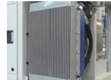
Воздухо-масляный теплообменник (стандартный)
