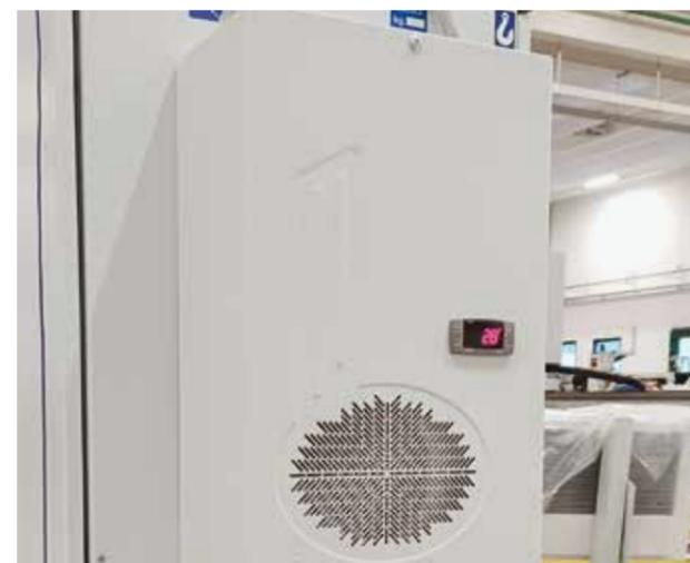
Unità di condizionamento dell'aria per il controllo di temperatura e umidità dell'armadio elettrico.
