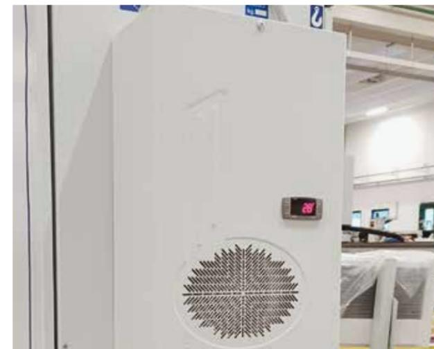
Unité de conditionnement de l'air pour le contrôle de la température et de l'humidité de l'armoire électrique.
